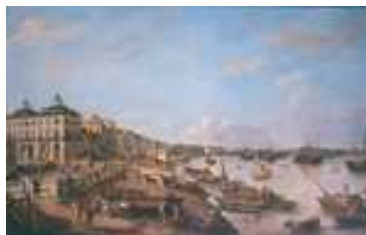
Pierre Lacour, vu d'une partie du port et des quais de Bordeaux dits des Chartrons et de Bacalan... 1804
