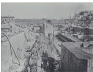
ALPHONSE TERPEREAU Bordeaux. Fondation du radier de la petite écluse. Vue prise d'en haut, 30 juillet 1873
