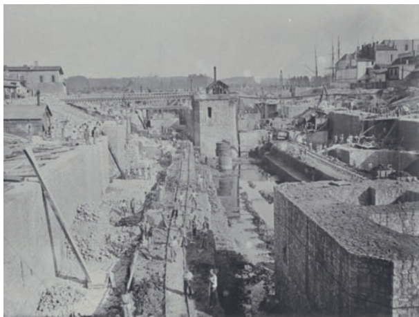
Nantes, 1839 – Bordeaux, 1897 Bordeaux. Fondation du radier de la petite écluse. Vue prise d'en haut 30 juillet 1873, Papier albuminé, carton écru, 35,1 x 48,5 Marne-la-Vallée, École nationale des ponts et chaussées
